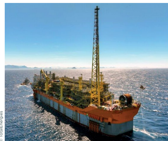
FPSO Sepetiba, Brésil
